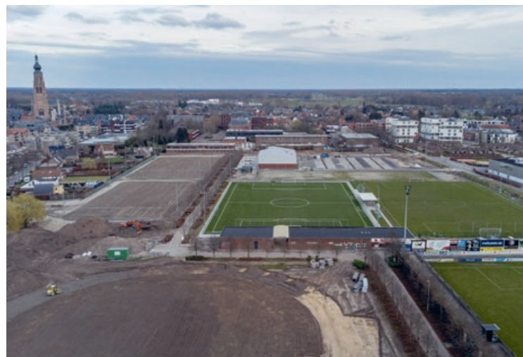
Werken in uitvoering voorjaar 2022.
